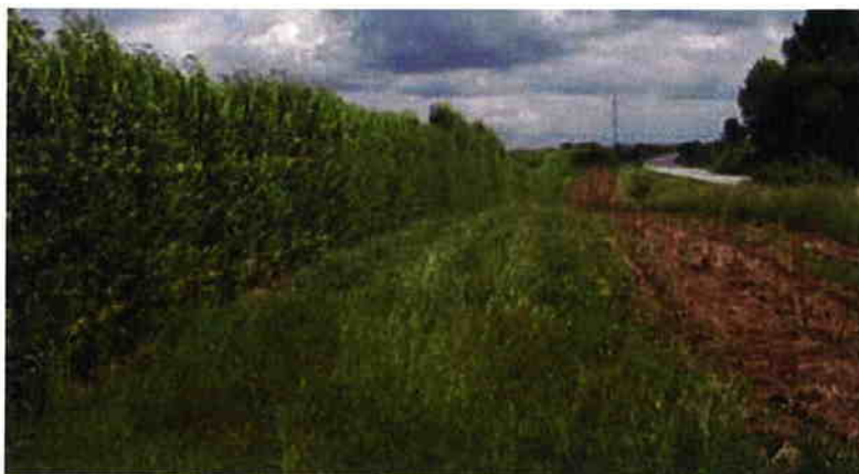
Støjskærm udført af pilehegn med lydisolering
